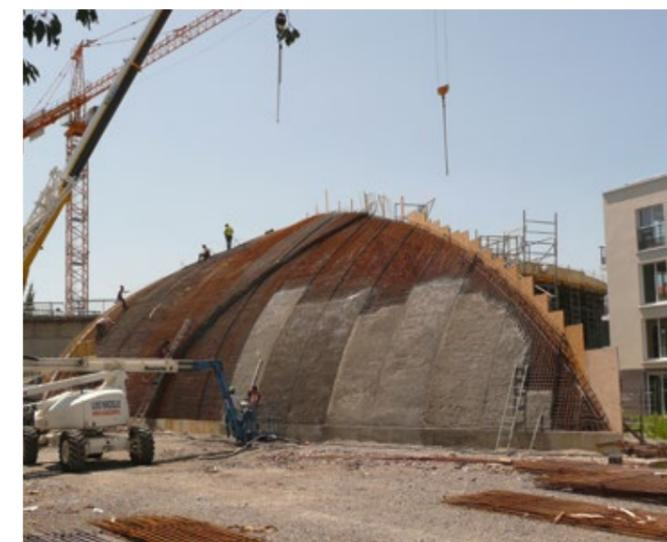
place et unifiées par une peinture blanche homogène. La coque de la salle polyvalente, dépourvue de joint de dilatation et lissée à la main pour permettre une finition peinte continue, a demandé une mise en œuvre du béton en surfaces alternées en damiers, par projection, pour garantir la pénétration du béton à travers une armature en acier dense, et pour absorber la rétraction du béton lors du séchage.
