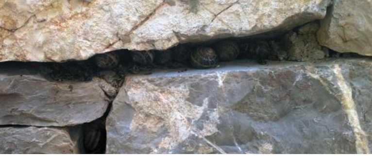
Mur de pierres sèches, corridor : escargots.
