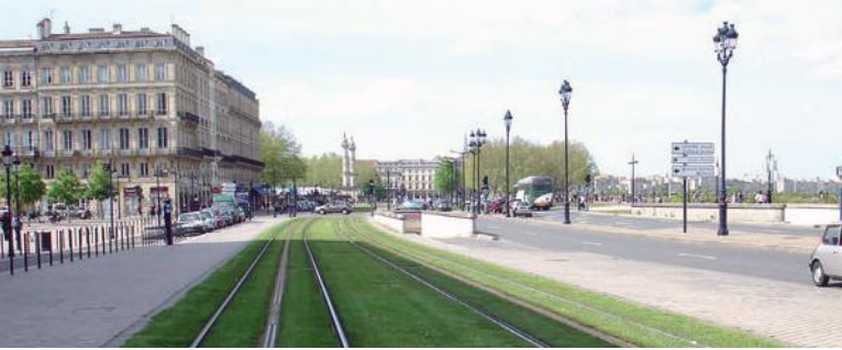
Voie de Tram enherbée, Bordeaux (33).
