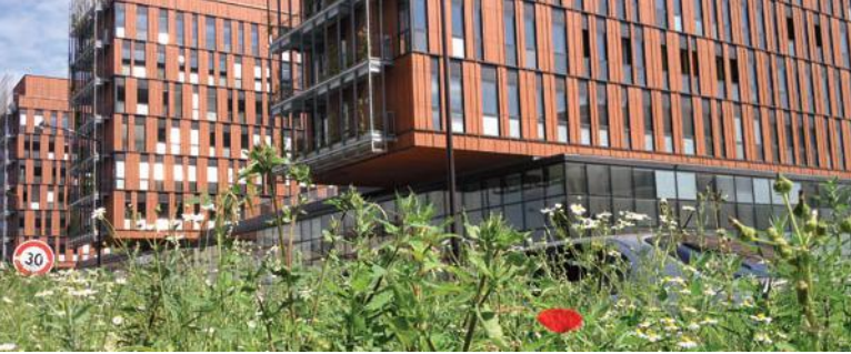
Porte d'Ivry (94). Architecte : P. Chemetov
