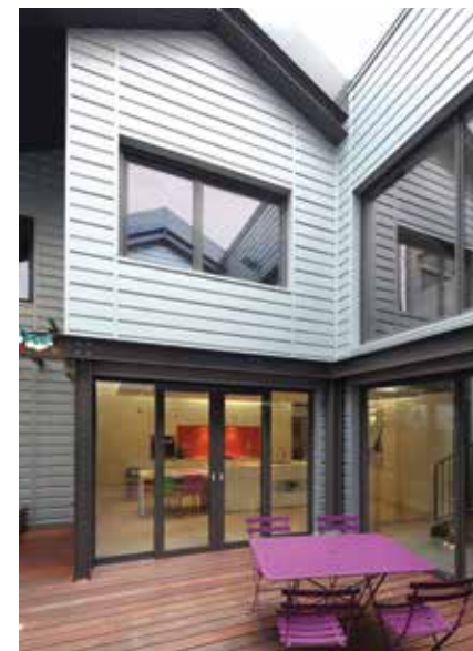
Le patio distribue la lumière dans les pièces de vie et constitue un espace extérieur protégé de la ville.
