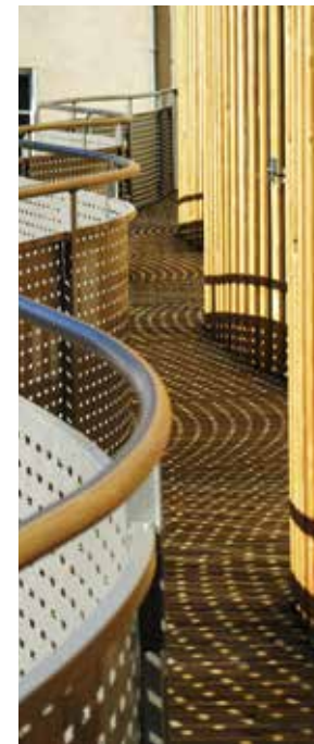
Les claustras mobiles assurent l'intimité des logements.
