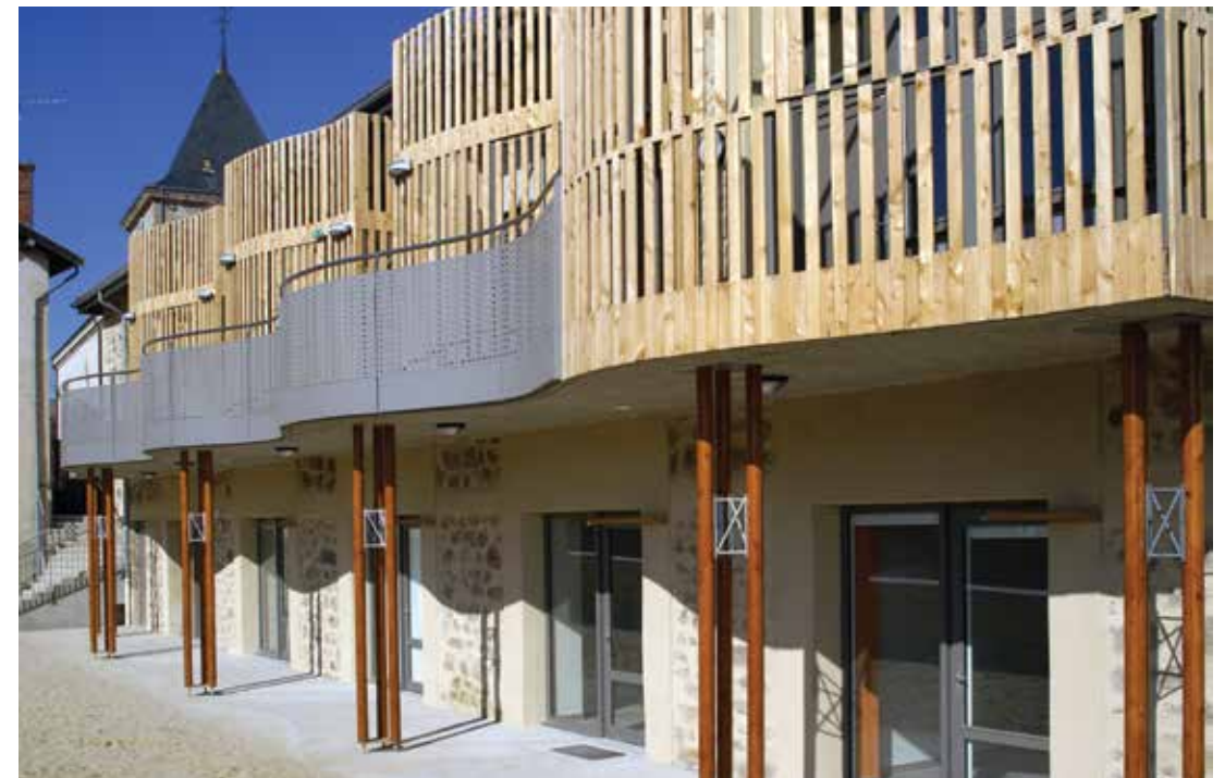
La coursive de l'étage fait office de protection solaire pour les salles du rez-de-chaussée.
