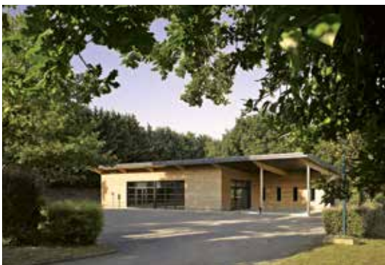
Maître d'ouvrage : Commune de Braize Maître d'œuvre : Agence d'architecture Stéphane Pichon
