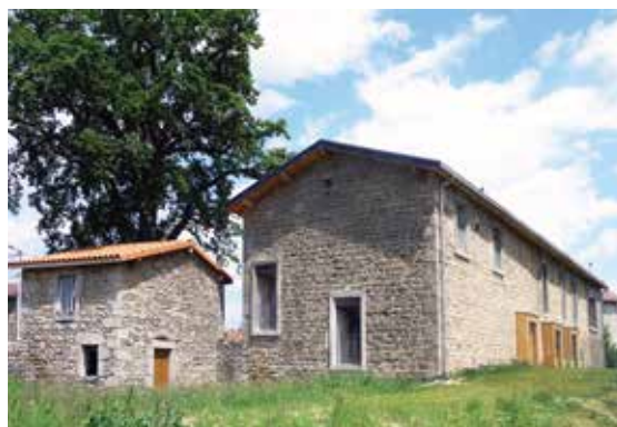
Maître d'ouvrage : Auvergne Habitat Maître d'œuvre : Agence Boris Bouchet architecte
