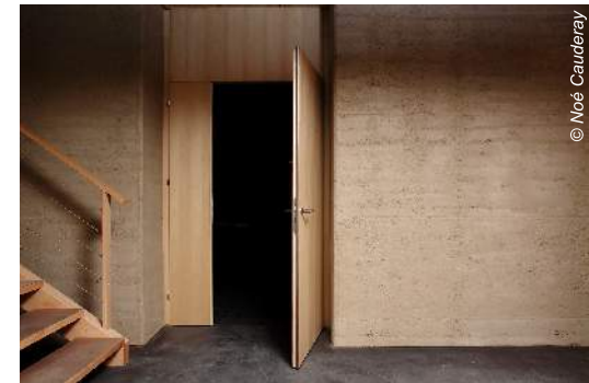
Mur masse en pisé (mélange de terre argileuse et de granulats) Eco46, Ville de Lausanne - Architecte : CArPE / Collectif d'Architecture Participative et Écologique
